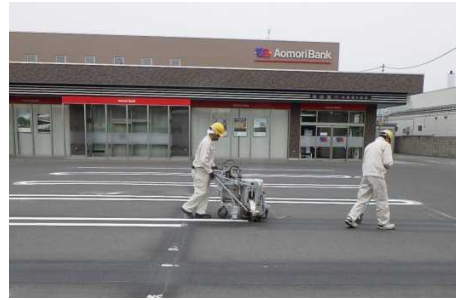
松原通り支店での施工(2021年5月)
