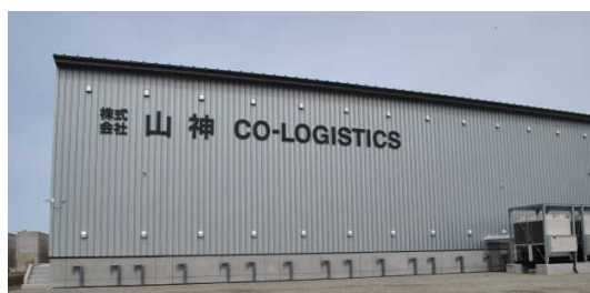
自動保管冷凍庫（外観）
