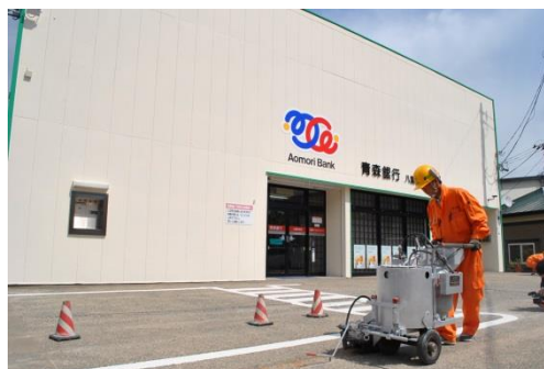
(八重田支店での施工 2019年5月)
