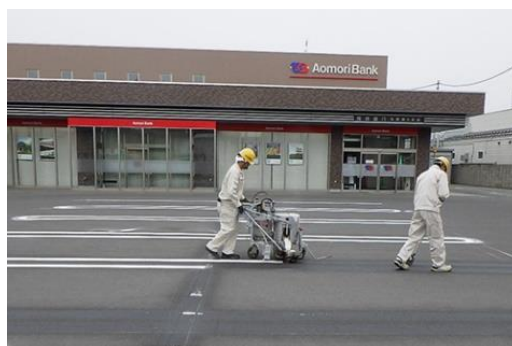
松原通り支店での施工(2021年5月)
