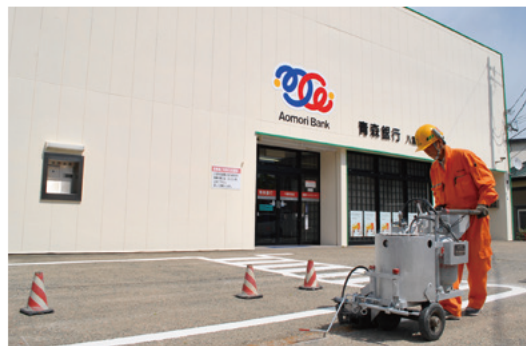
(八重田支店での施工 2019年5月)
