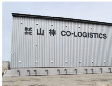
自動保管冷凍庫
