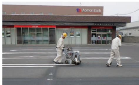
松原通り支店での施工(2021年5月)
