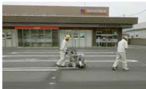
松原通り支店での施工(2021年5月)
