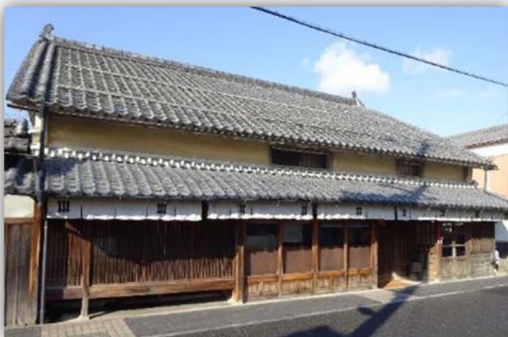
【ONAE 棟：5 棟共通のフロントがある】
