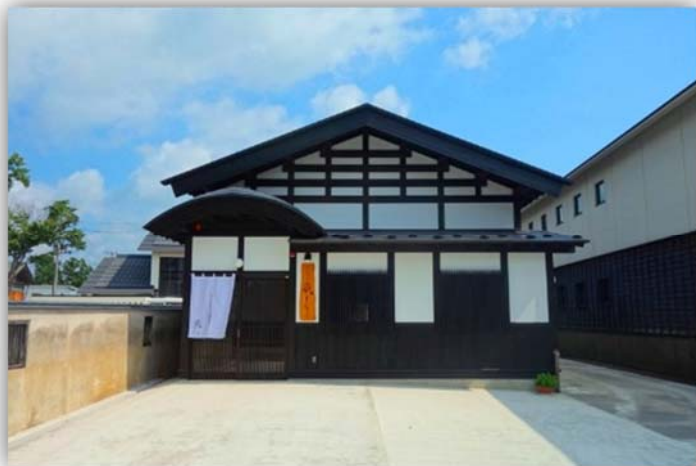
【改装後の外観】
