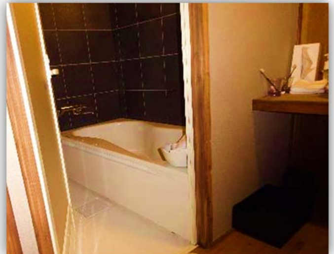
【ONAE 棟内部：水回りに関しては現代風のユニットバスを用いている】
