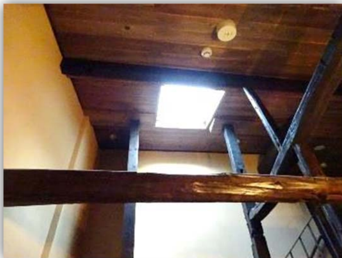
【法規上、採光や排煙等のための天窓設置が求められた】
